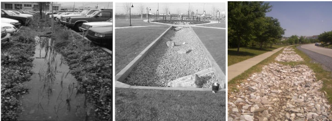
Figura 28 – Esempi di trincee d’infiltrazione
